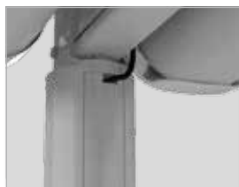
Câblage confortable grâce à des gaines intégrées dans les poteaux.
